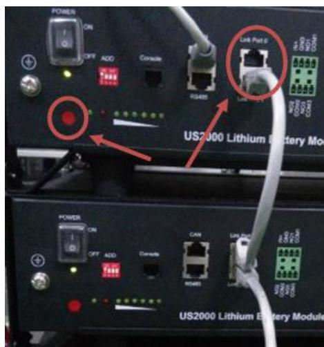
(3) Appuyer sur le bouton rouge de la Batterie Principale pour mettre en marche l'ensemble et tous les témoins LED s'allumeront un par un à partir de la Batterie Principale :
